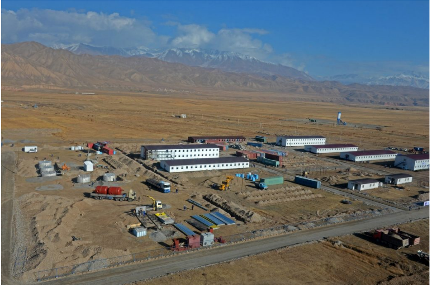
Строительство Верхнеарынского каскада ГЭС на данный момент заморожено/president.kg
